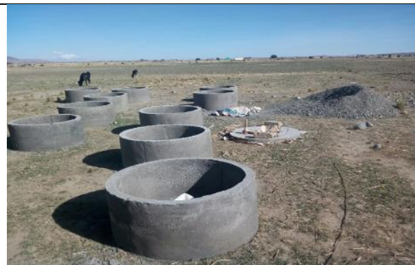
Construcción de anillas para pozos
