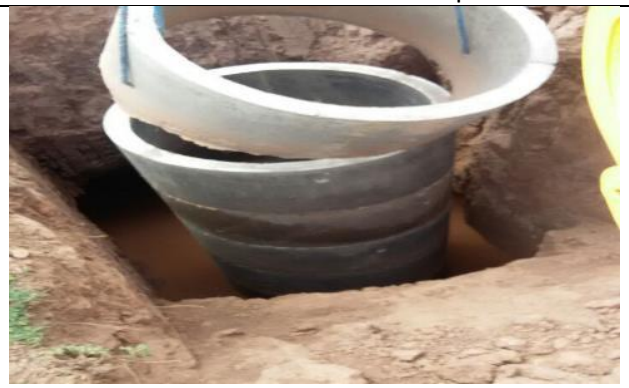
Introducción de anillas para pozos
