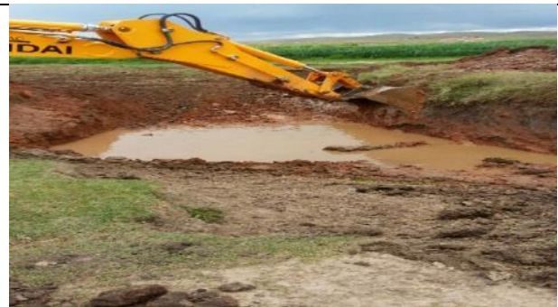
Construcción de sistemas de cosecha de agua de lluvia (Qotañas)
