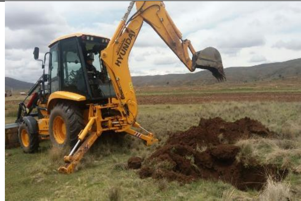
Excavación de pozos con pala mecánica IMSA
