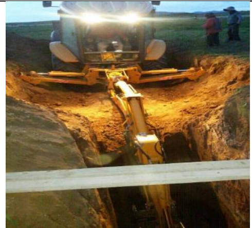
Detalle de la excavación de pozos
